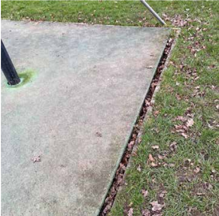
Image 1 Wet pour shrinkage
